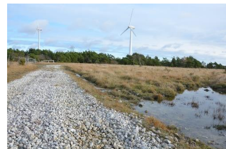
Väg som dragits för etablering av vindkraftsverk, och som är tänkt att avvecklas
